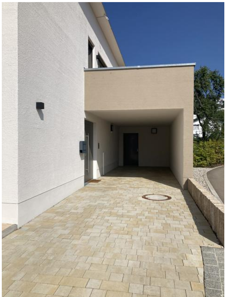
Blick vom Hof Richtung Carport
